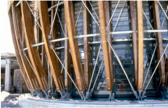
Principe d'exo-squelette en poutres lamellées-collées
